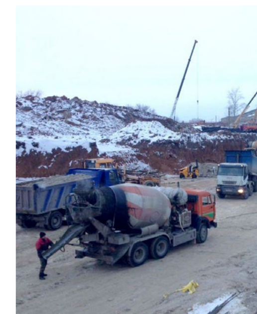
Закладка фундамента новой БСМП, январь 2017 года.
